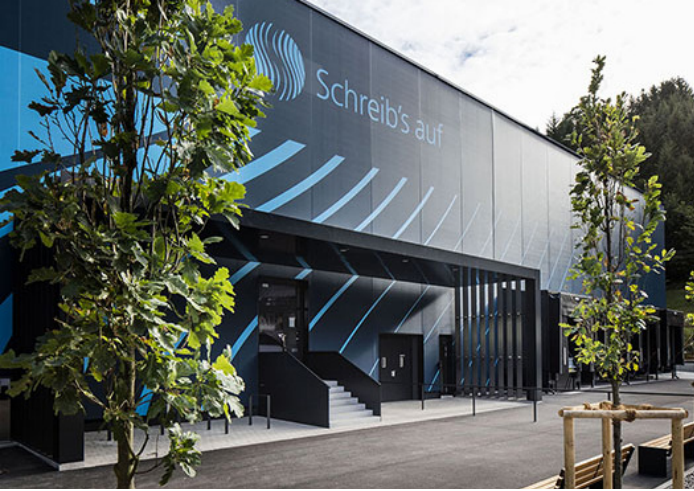
Das Schneider-Logistikzentrum blug in Tennenbronn.
