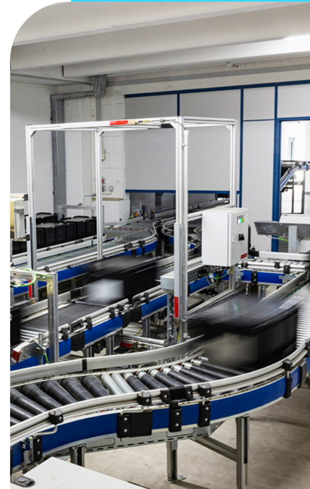
Vollautomatisierte Fördertechnik zur Ein- und Auslagerung.
