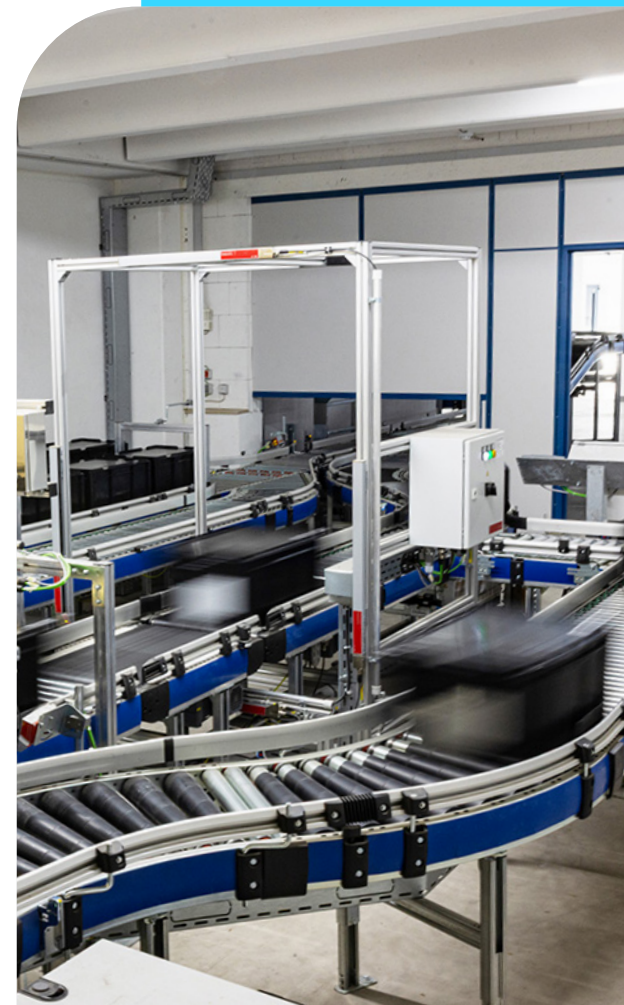
Système de convoyage entièrement automatisé pour le stockage et le déstockage.
