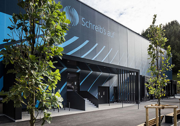
Le centre logistique Schneider blulog à Tennenbronn
